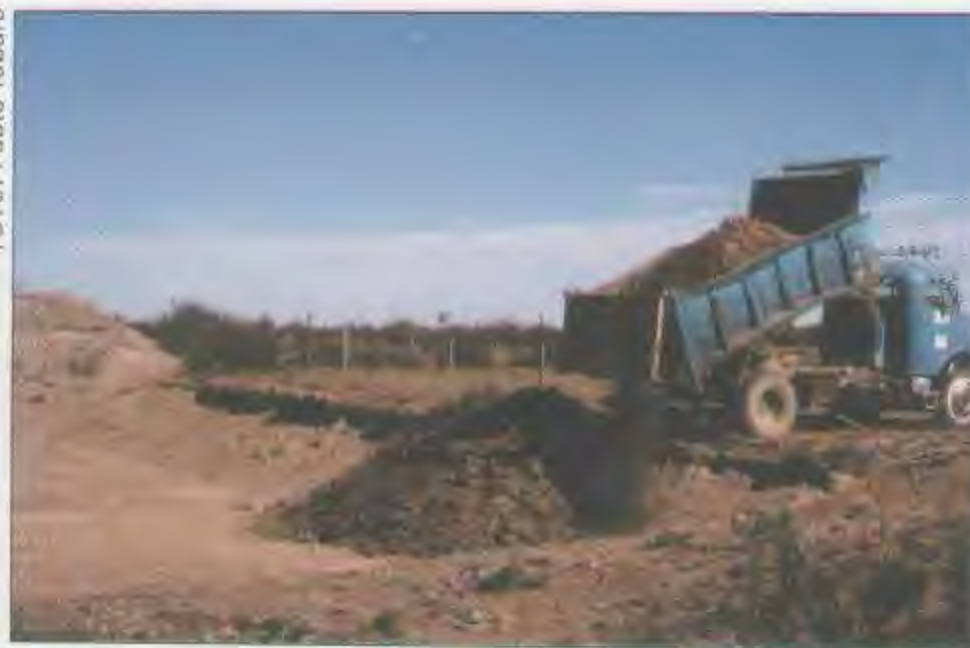
Las piletas con petróleo fueron rellenadas para evitar accidentes en la fauna.
