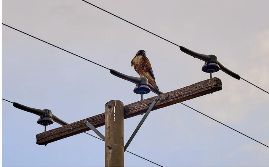
▲ La forma más efectiva de intervención de líneas de distribución de energía para evitar la electrocución es el aislamiento de los cables energizados o la modificación de su estructura. En la imagen, un individuo juvenil de **aguilucho ñanco** posado sobre cobertores aisladores que evitan el contacto del ave con los cables.
