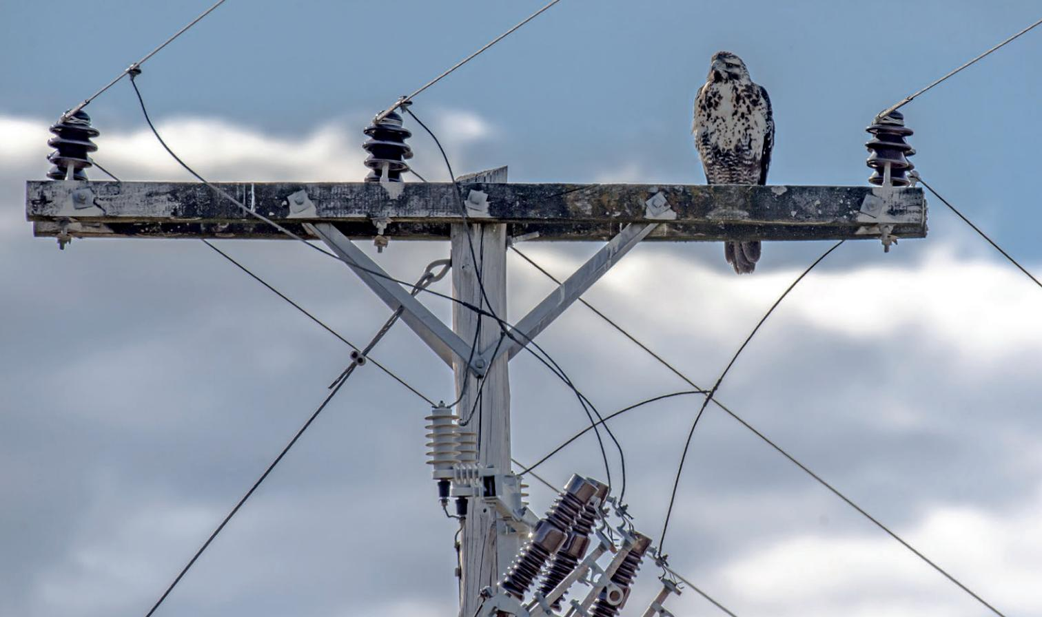
▲ **Juvenil de águila mora** posada en una cruceta de un poste de línea de distribución. Los aisladores rígidos en forma vertical y el cableado hacia los interruptores en la parte inferior, aumentan la probabilidad de contacto del ave con dos de las fases o cables en forma simultánea, posibilitando así su electrocución.
