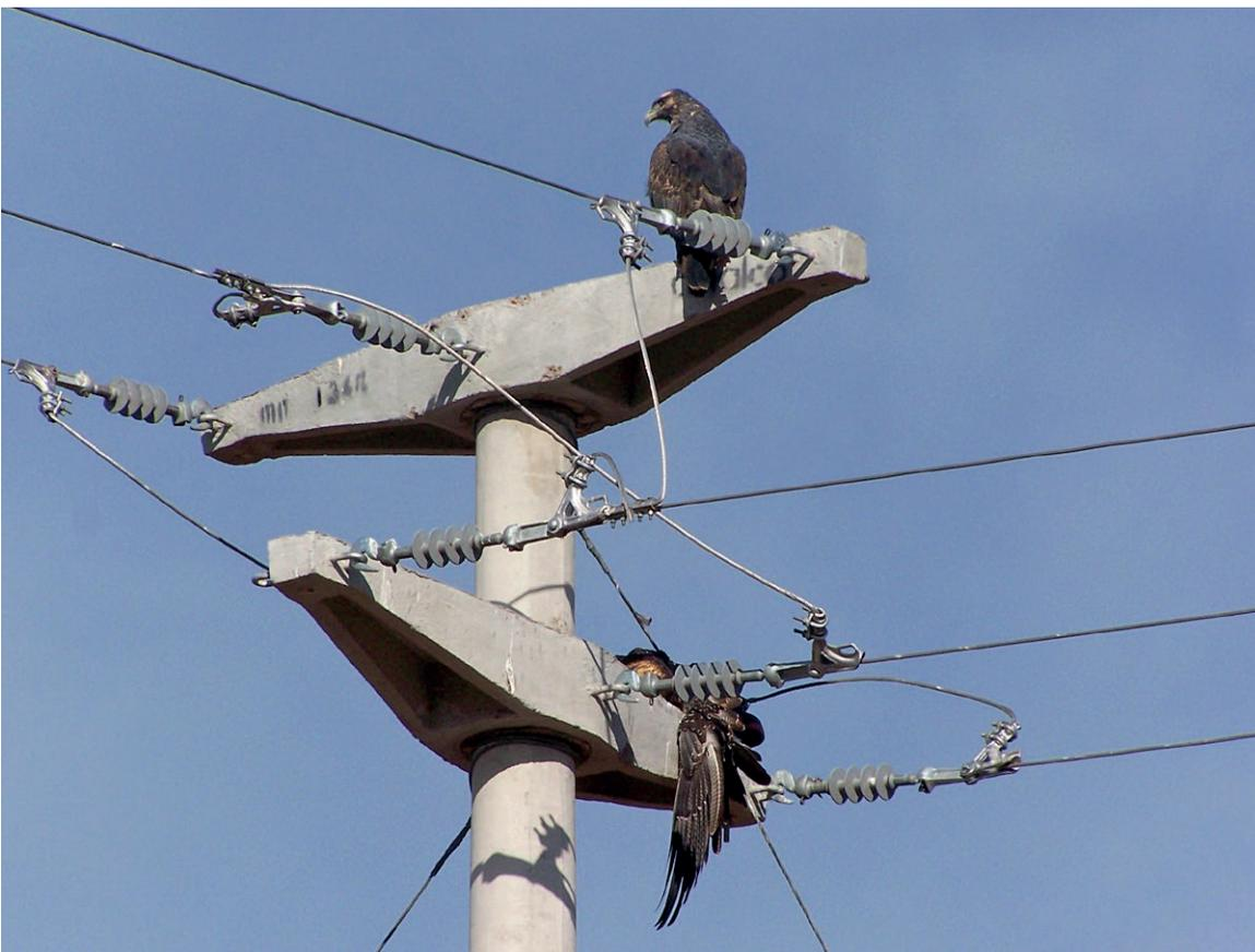
◀ Estructuras para el cambio de dirección de un tendido eléctrico con postes de hormigón. Los empalmes de las fases, al no estar aislados, lo convierten en un poste letal. Se observan dos ejemplares de **águila mora**, el de abajo electrocutado por contacto fase-fase o fase-descarga a tierra. Había más ejemplares muertos en la base.
